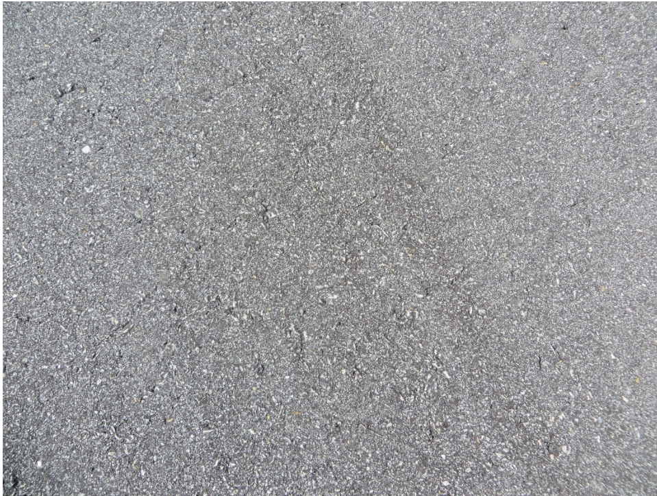
R1331WI-10. Raveling (Sample Unit No. 13).
