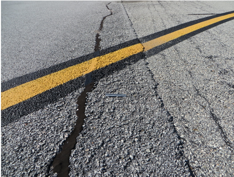
TAML-10. Raveling (Sample Unit No. 02) (1).
