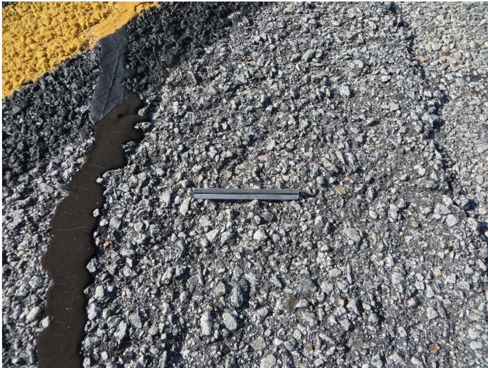
TAML-10. Raveling (Sample Unit No. 02) (2).
