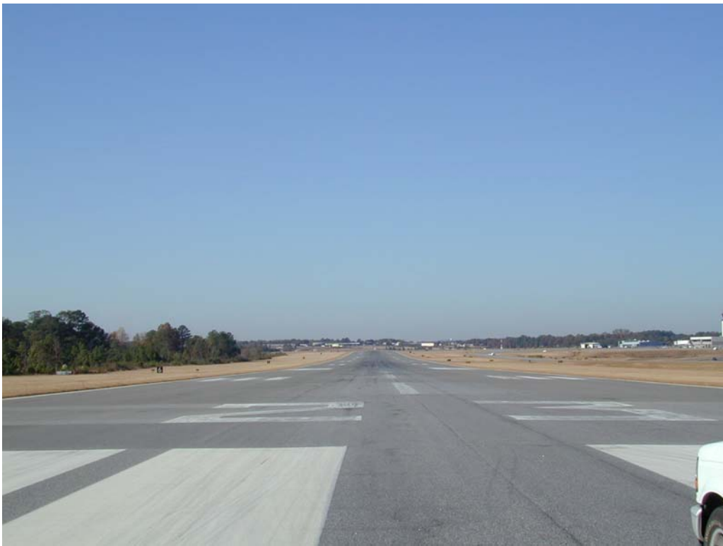
Overview of section R523CL-10C.
