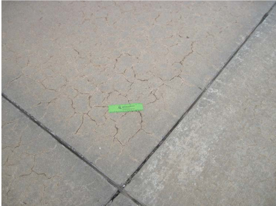
ATERMVL-10. ASR (Sample Unit #6).
