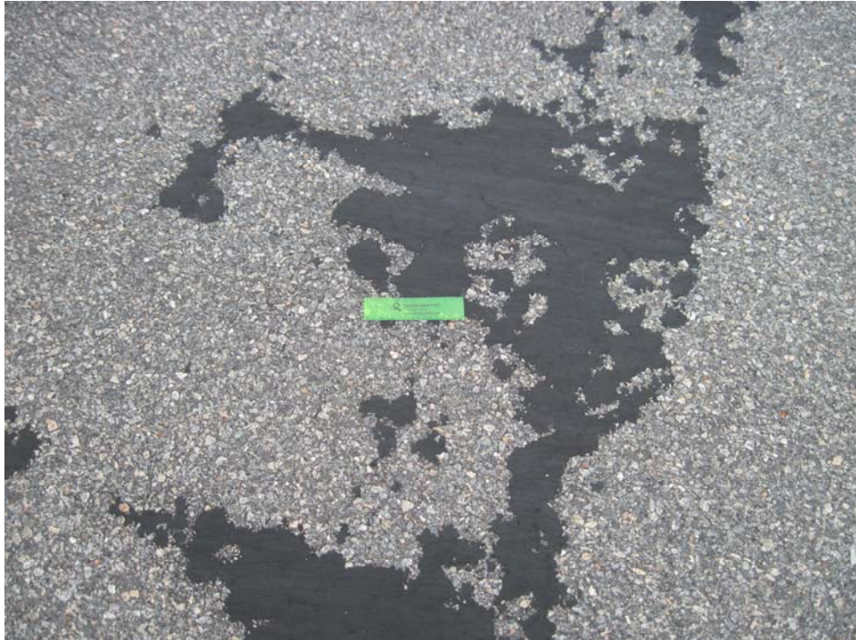
TNVL-10. Bleeding (Sample Unit #1).
