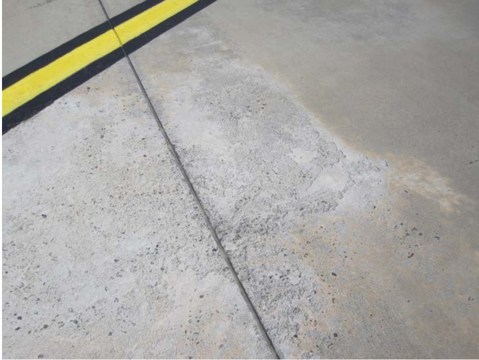
ACARGOSV-10. Scaling (Sample Unit #03).
