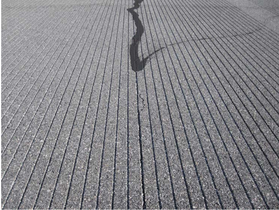
R1028SV-10N. Longitudinal and Transverse Cracking (Sample Unit #46).
